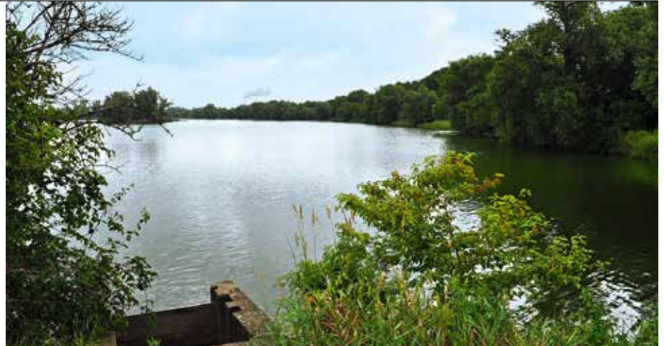
Blick auf einen Karpfenteich mit Auslassbauwerk (Ständerbauwerk) im Vordergrund
